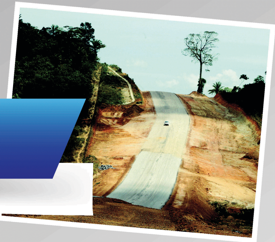
Obra do Anel Viário de Candeias .
