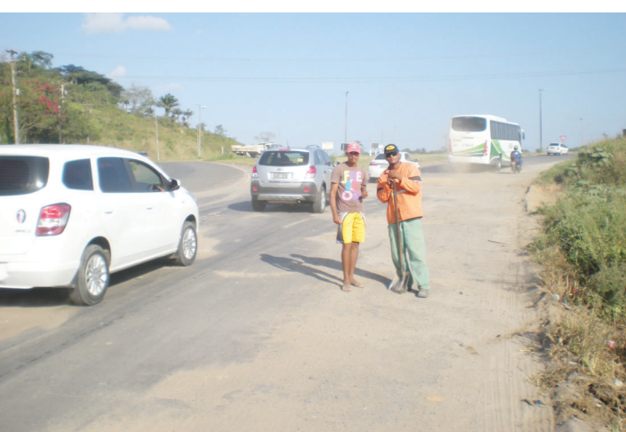
No trevo da Moliza, assim como em outros trechos da BA, os buracos voltaram depois das ultimas chuvas
